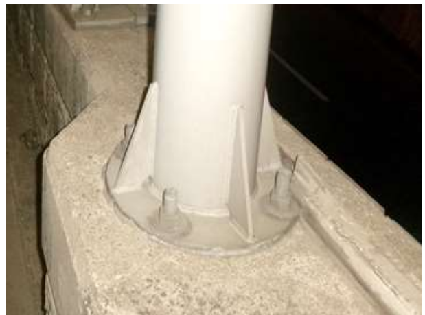
안전 및 기타시설(조명설비(외부 가로등)) 상태현황
