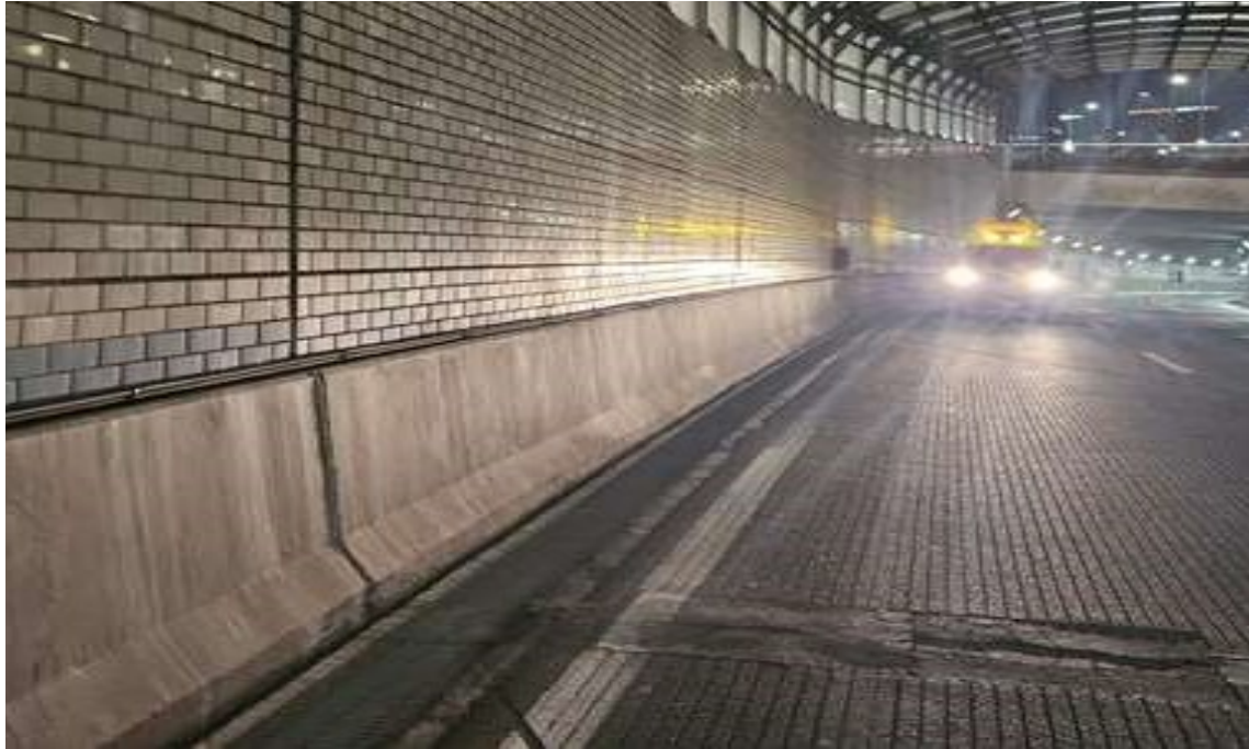
내부 배수시설 전경
