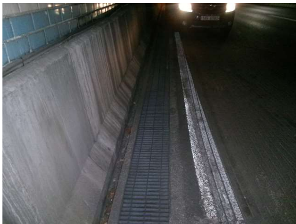
S1 배수시설 상태현황
