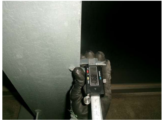
방음터널 부재치수 측정
