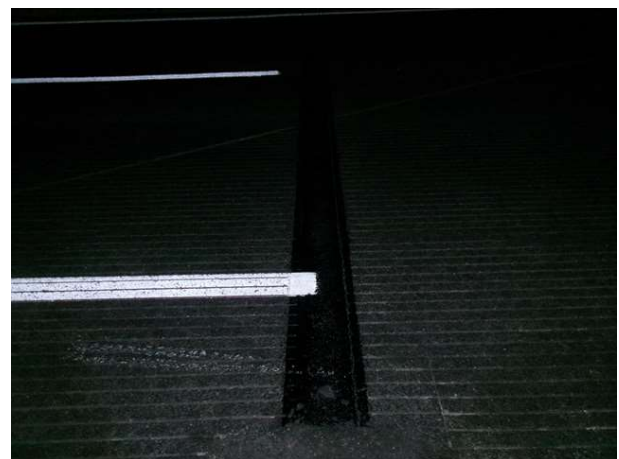
S2 도로부 신축이음부 상태현황
