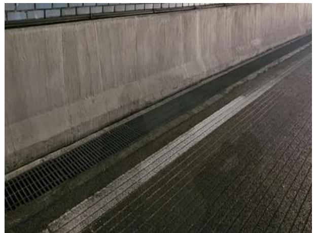
S2 배수시설 상태현황
