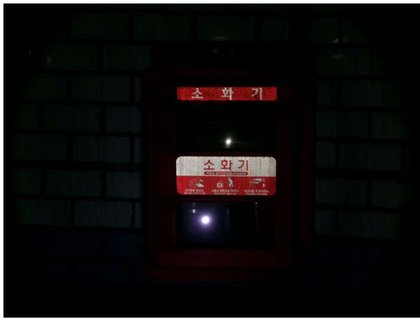
방재시설(소화기) S01 상태현황
