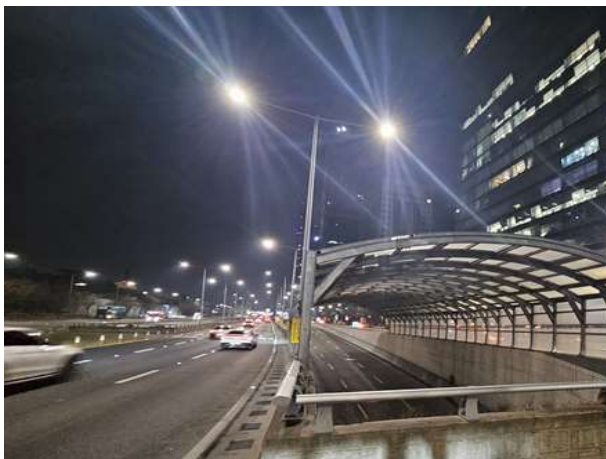
안전 및 기타시설(조명설비(외부 가로등)) 상태현황
