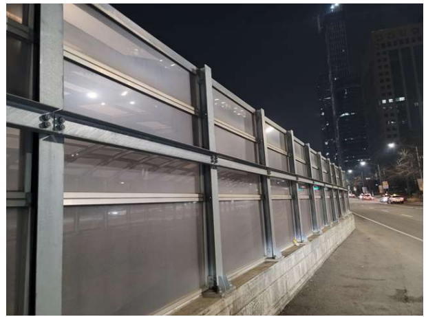
외부 보조골조 전경
