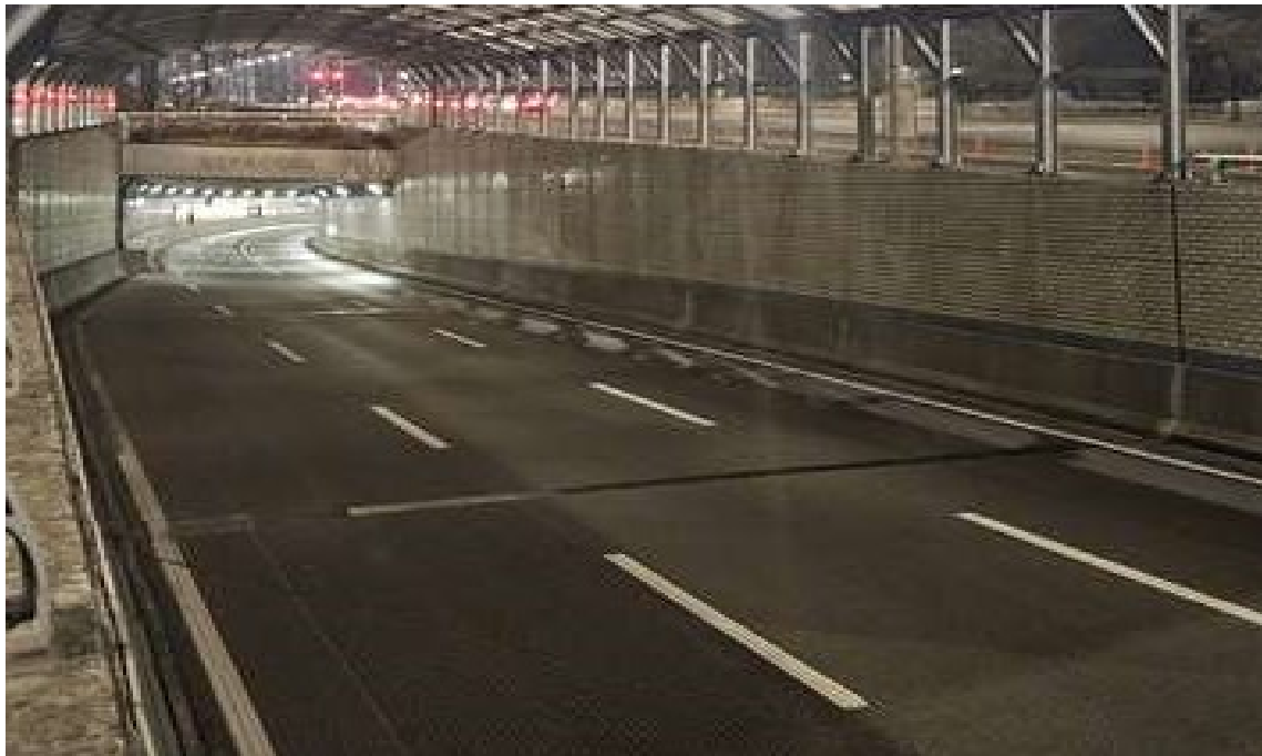
내부 도로포장 전경
